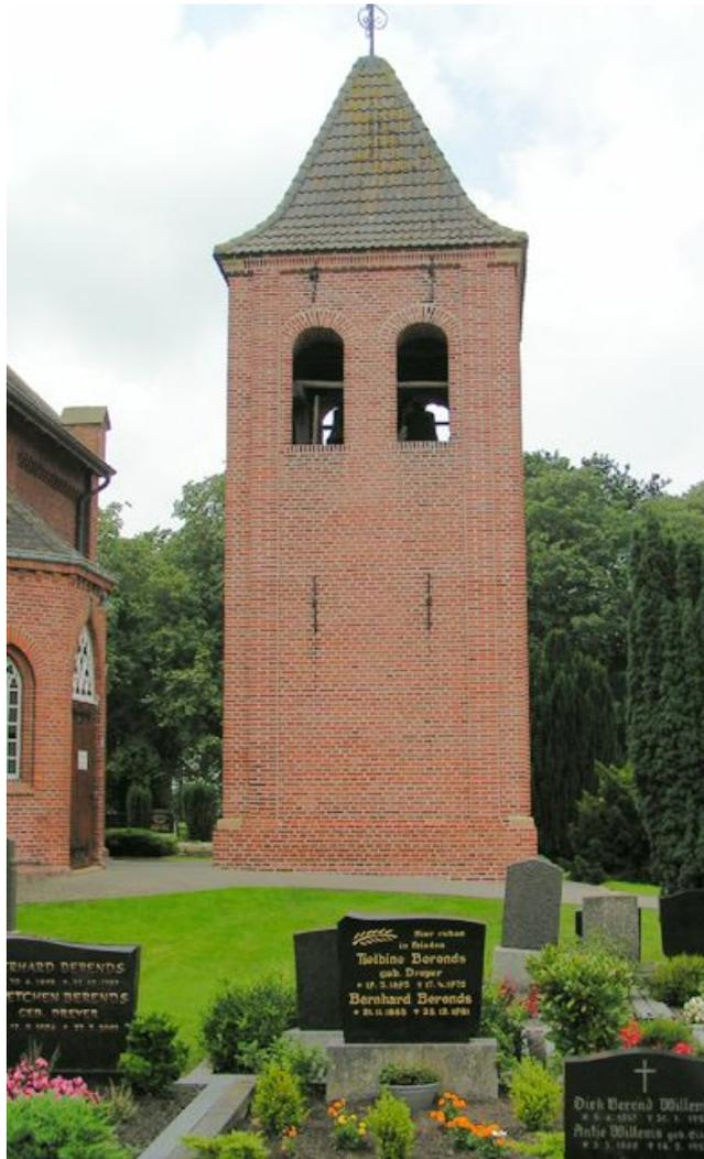
Das einst auf Moorboden erbaute Kirchenschiff steht mittlerweile auf einer Betonplatte. Der 1788 errichtete **Glockenturm** mit einem Pferd auf der Spitze wurde separat neben der Kirche errichtet. Diese Bauweise hat einen praktischen Grund. Der ohne Fundament gebaute Turm wäre weggesackt und hätte das übrige Mauerwerk mitgerissen.
