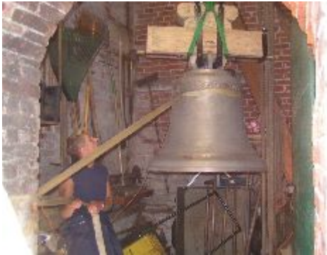
15. Juni 2005. Die neue "g" Glocke wird hochgezogen.
